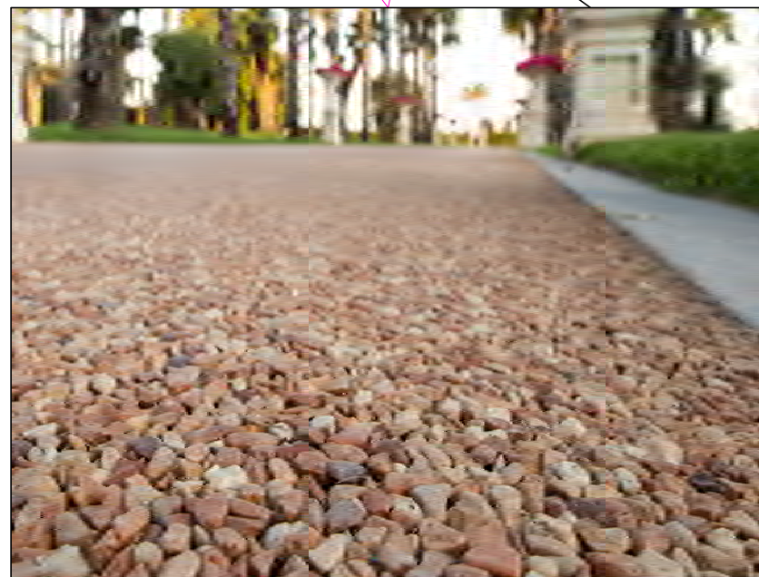
Pavimentazione in ghiaio lavato
