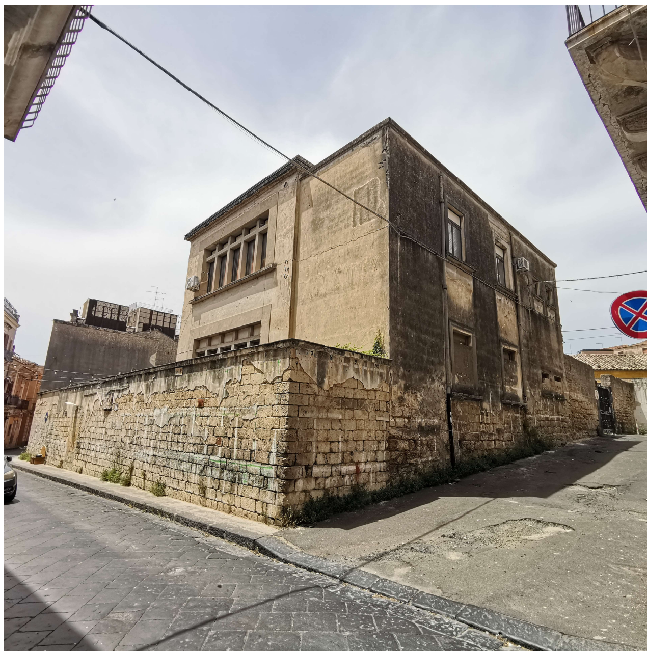
Foto 1 – Muri di recinzione da via Roma
