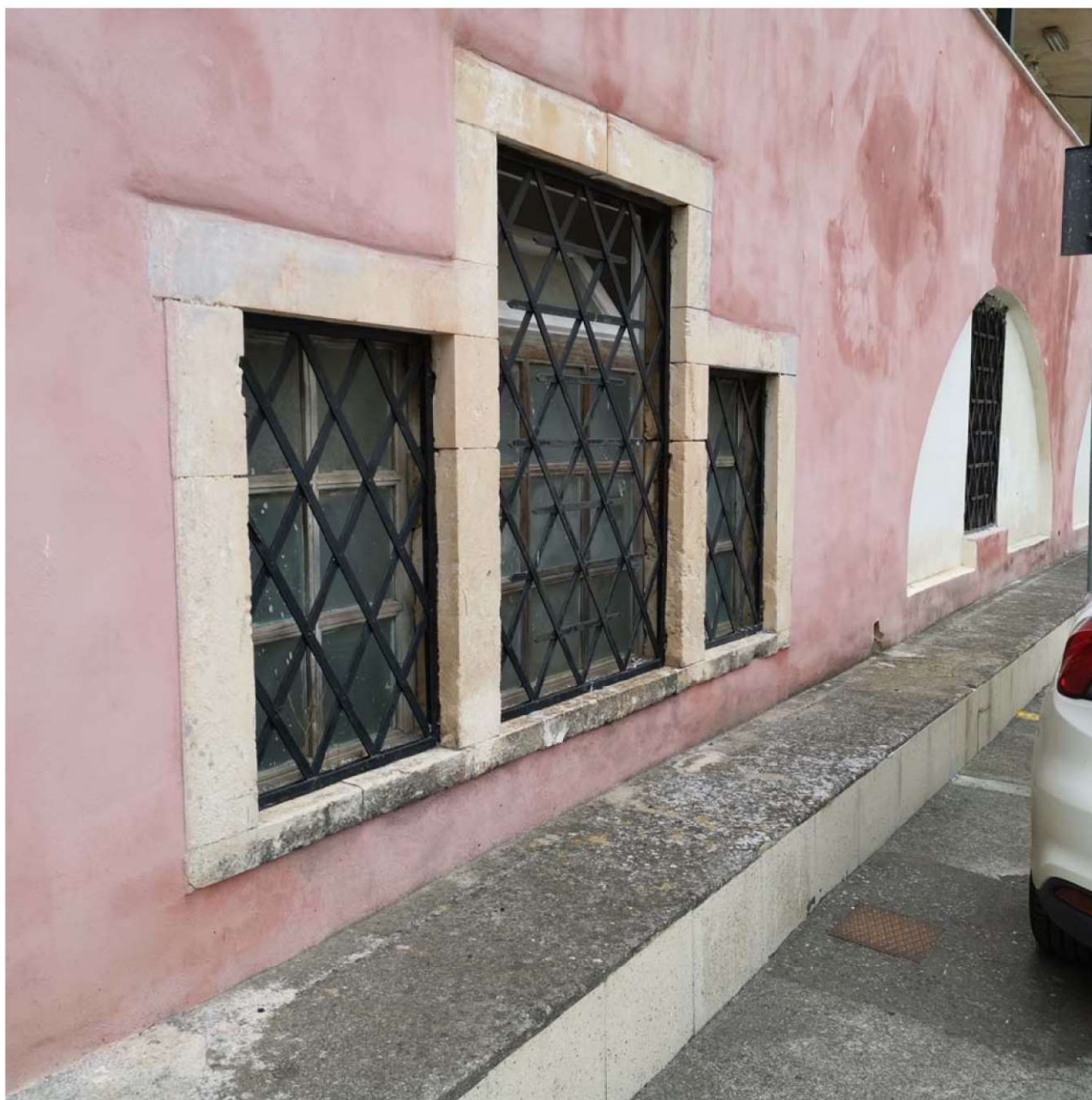
Foto 13 – Prospetto uffici comunali
