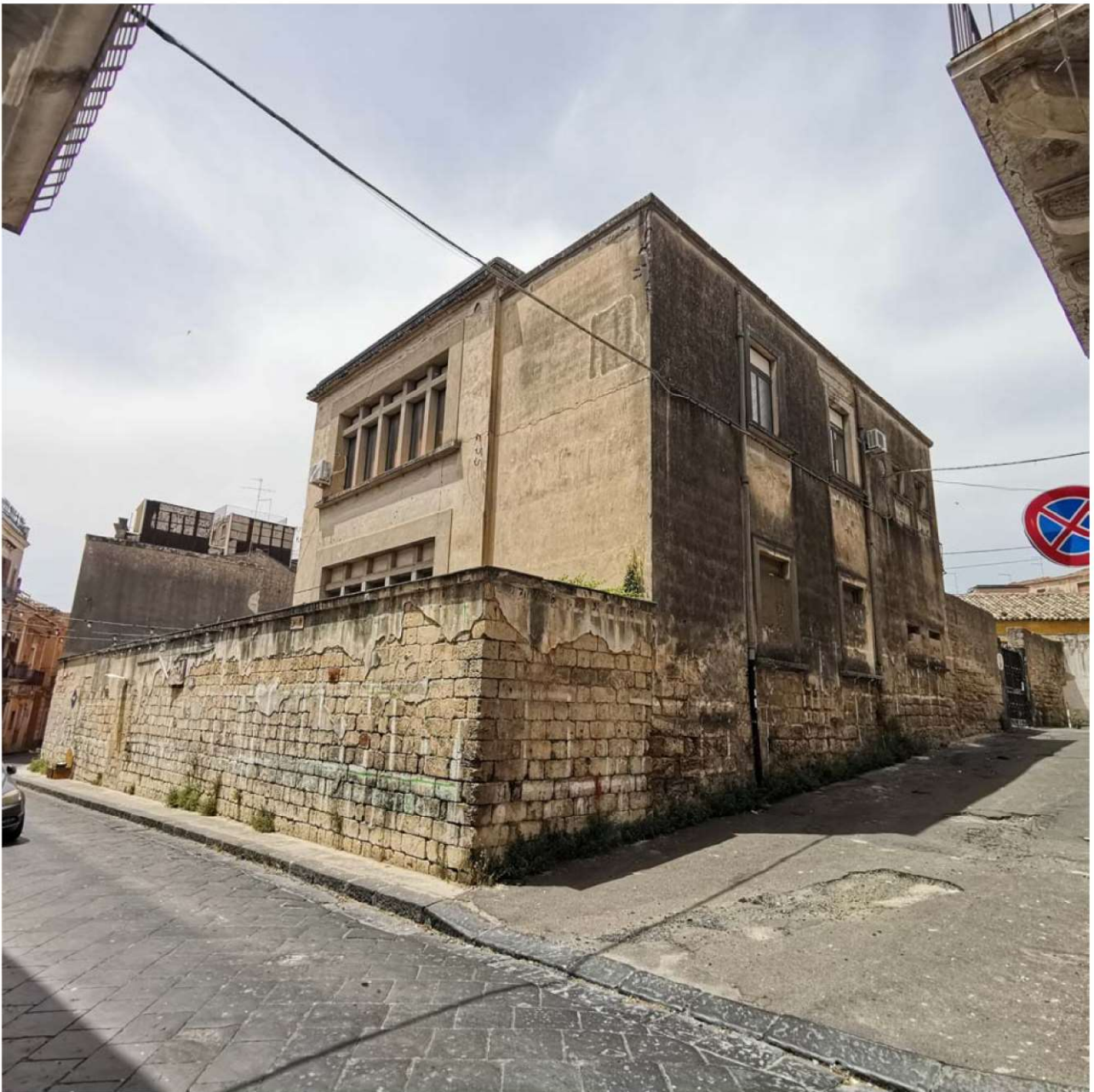
Foto 04 – Muri di recinzione via Roma angolo via Italia
