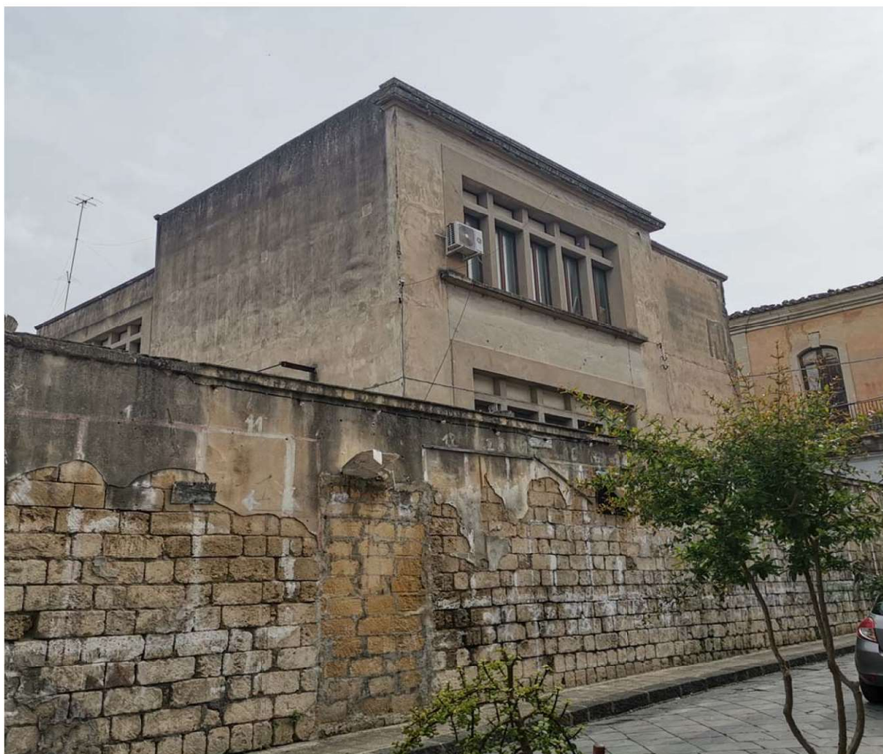
Foto 01 – Muri di recinzione da via Roma
