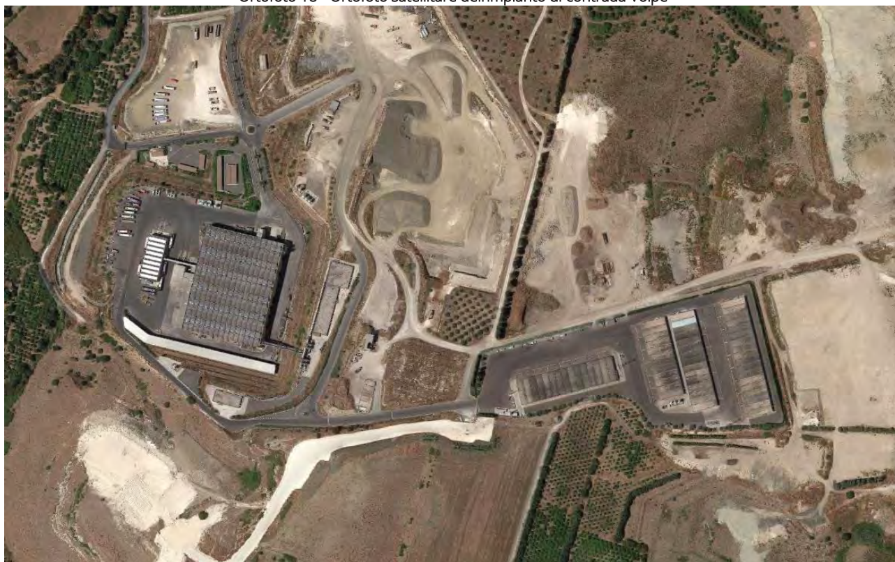
Ortofoto 18 - Ortofoto satellitare dell'impianto di contrada Volpe
